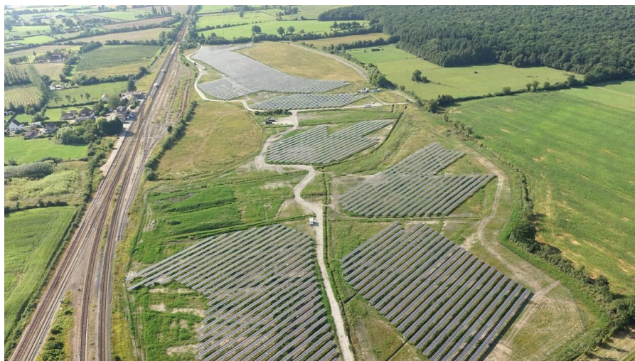
La ferme solaire de Surdon
